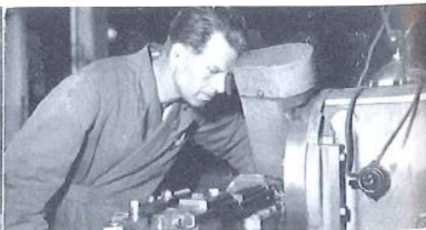
Fräsningen av spåret i spiralskruvmejselns spindel fordrar stor noggrannhet.
