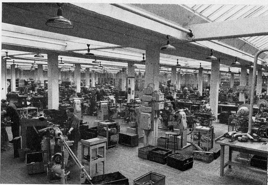
Tångavdelningen — del av fabrikshallen.
